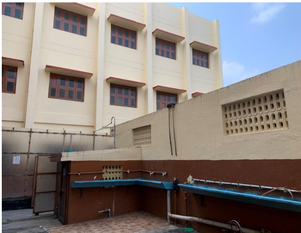
Huidige toiletgebouw in Ramapuram
